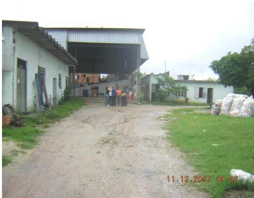
Figura 1 – Área Externa com galpão de triagem ao fundo.
